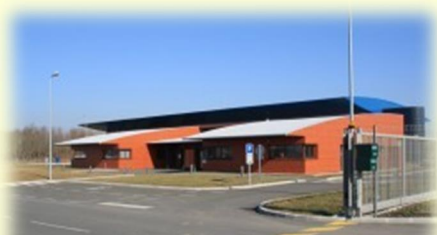
Site de Tri Selectif des Emballages SMEVOM de Digoin
